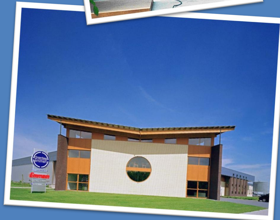
EEN VAN DE GROOTSTE PROJECTEN: NIEUWBOUW DRENTEA IN EMMEN
